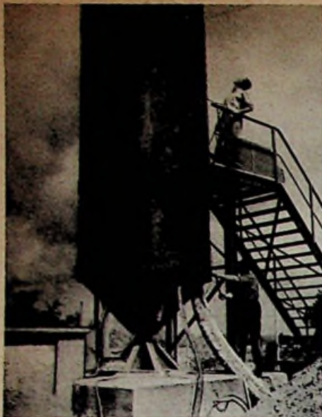
Mehr als 70 Tonnen drücken auf den Betonklotz unter dem Rohrmast. Rechts Einstieg zum Fahrstuhl. Aufn.: Hans Müller
